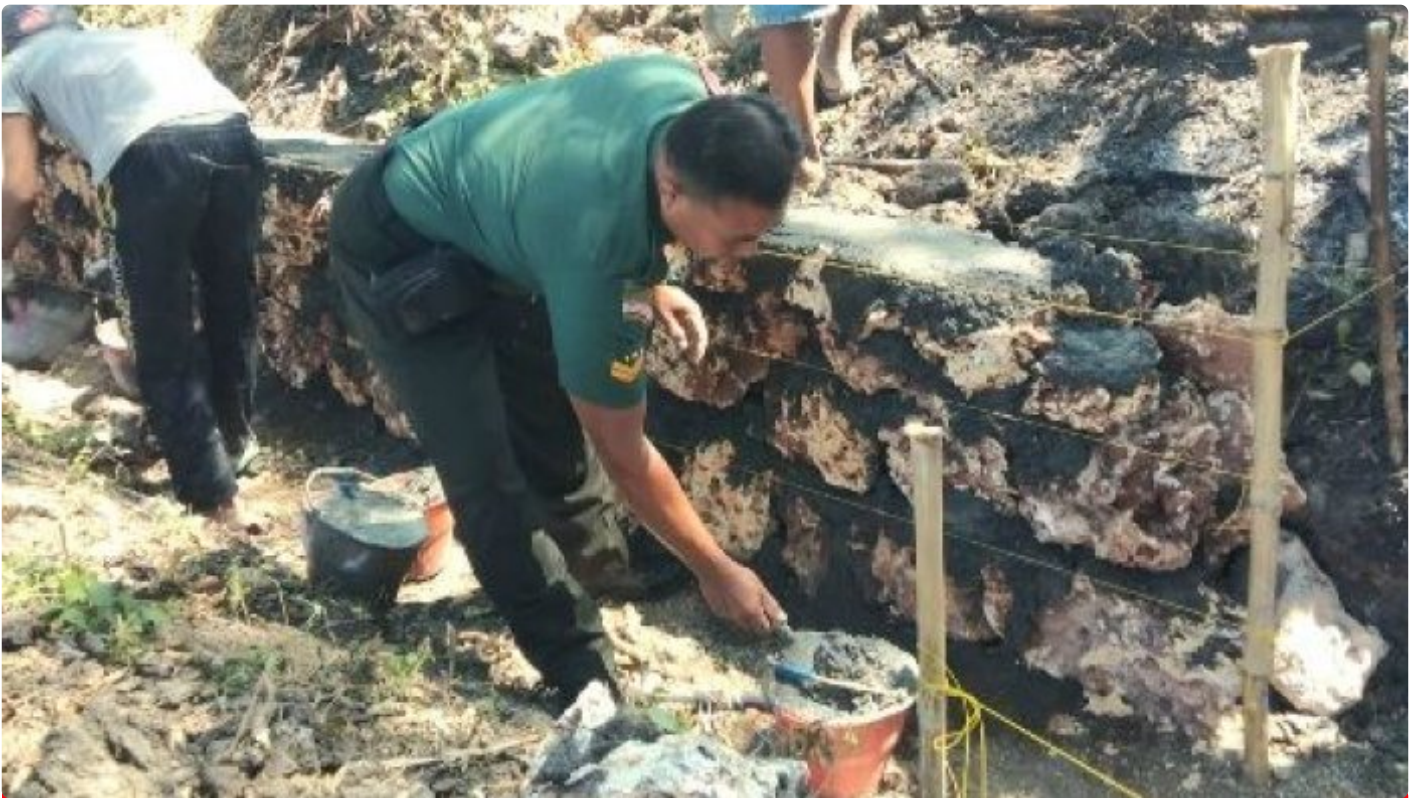
Babinsa Koramil 0829-12/Modung saat membantu pemasangan batu pembuatan irigasi
